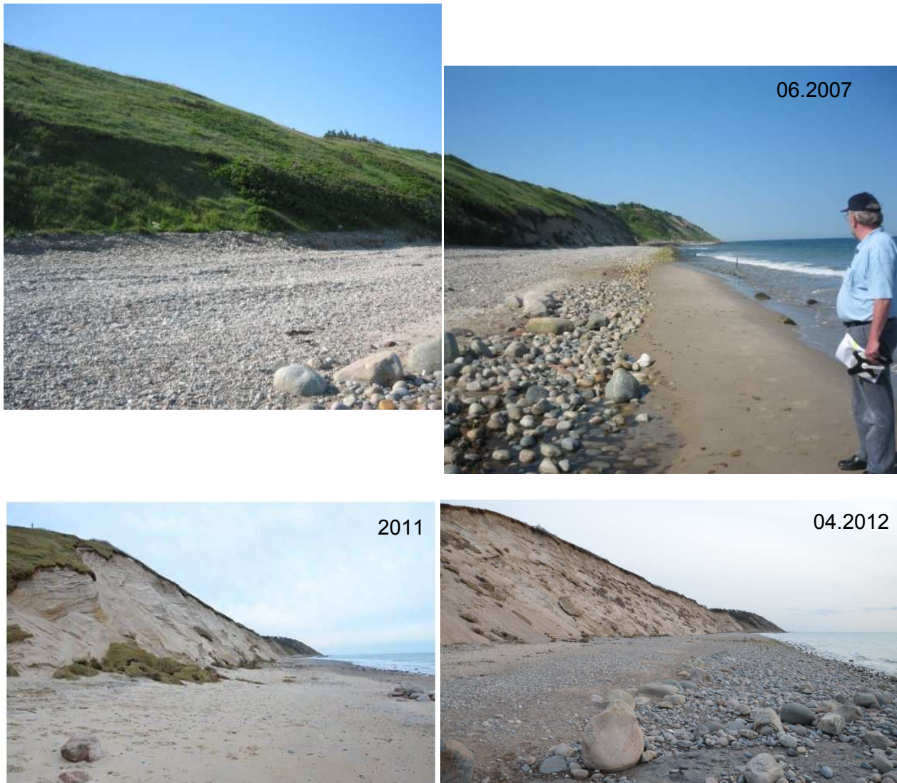
Figur 5-9 Udviklingen af erosionen af skråningerne langs den østlige del af Vincentstien ud for Hanebjerg Skovvej 48 (G)
