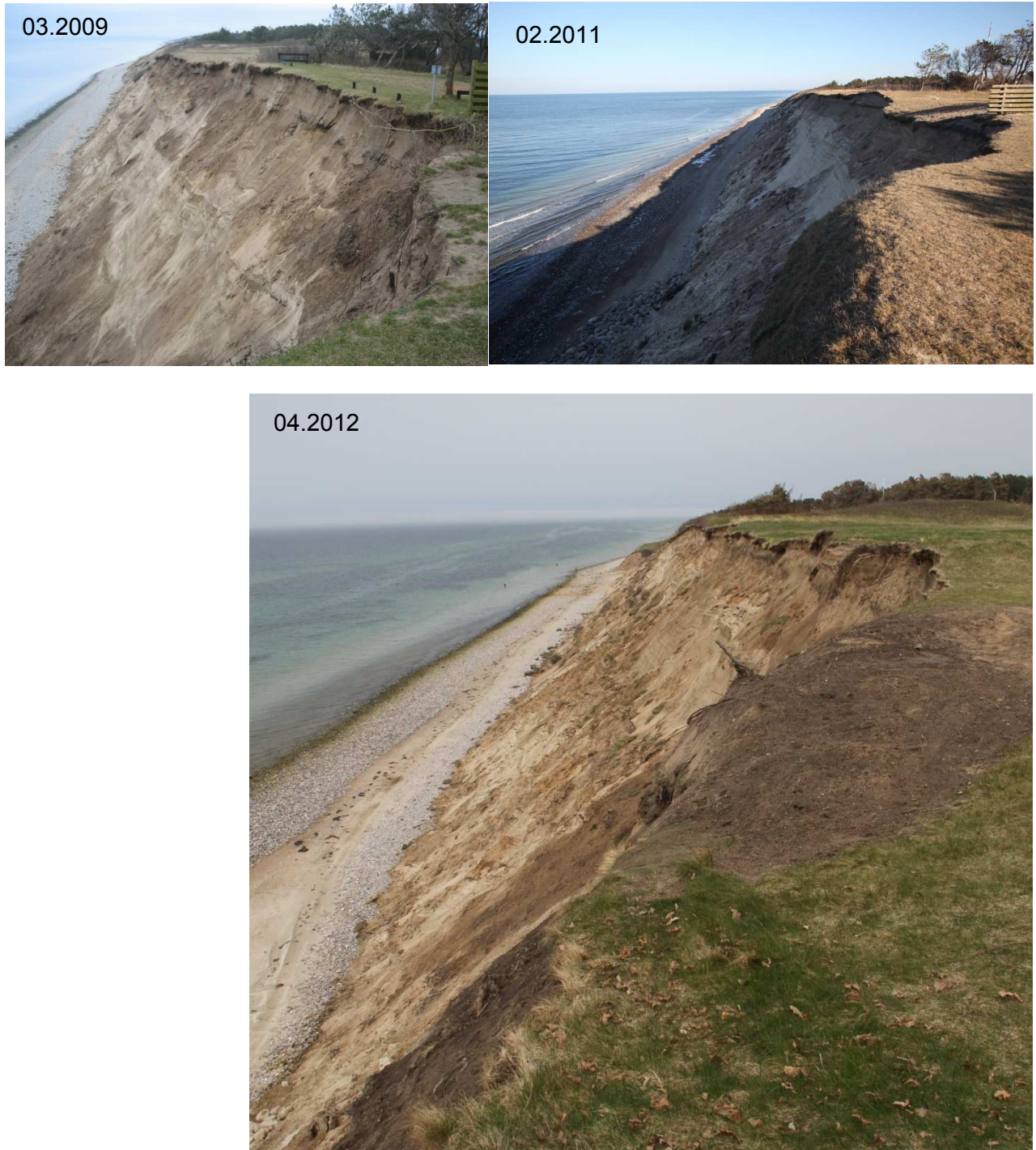
Figur 5-4 Omfattende læsideerosion af stranden og skråningen øst for den sidste skråningsbeskyttelse. (C)
