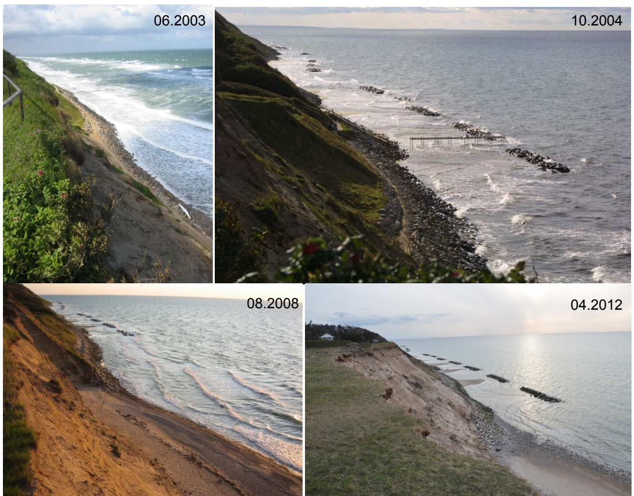
Figur 5-6 Udbygning af hård kystbeskyttelse og accelererende læsideerosion (D)
