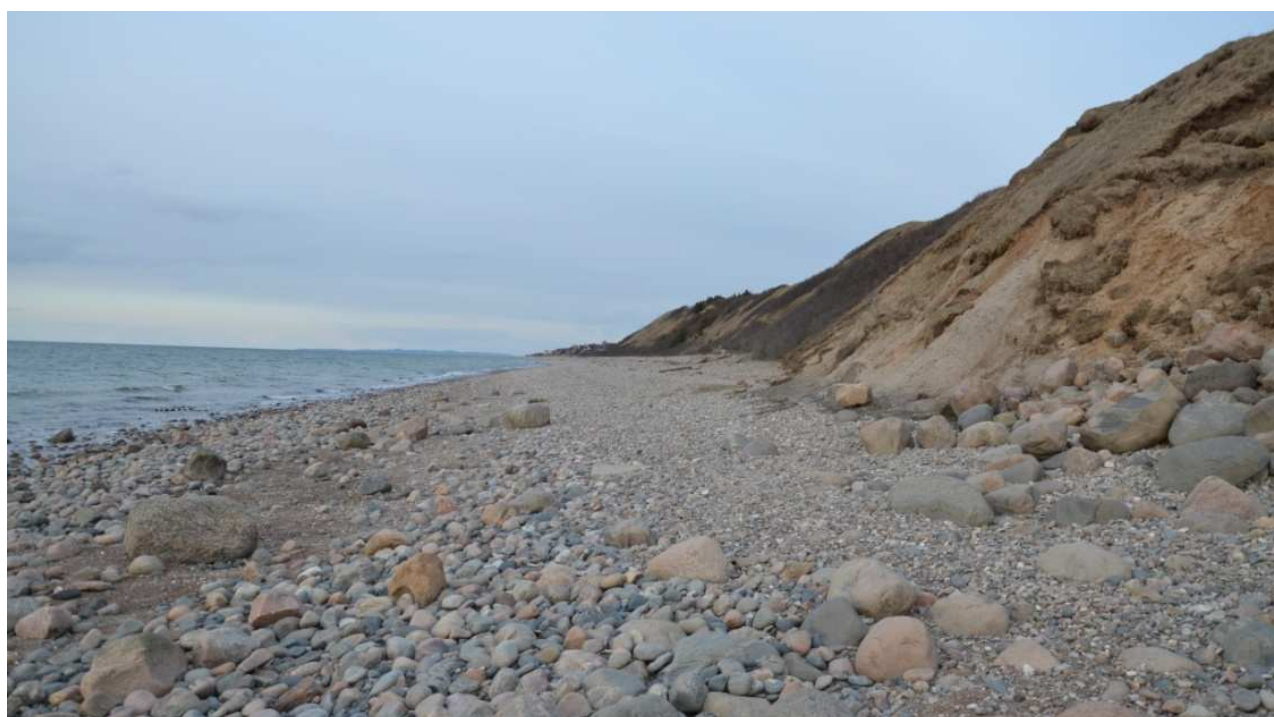
Figur 5-12 Erosion af skråningerne ved Heatherhill, 03.04.2012 (J)
