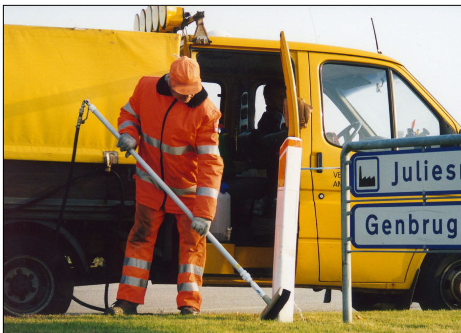
Figur 4. Afvaskning af kantpæle.
