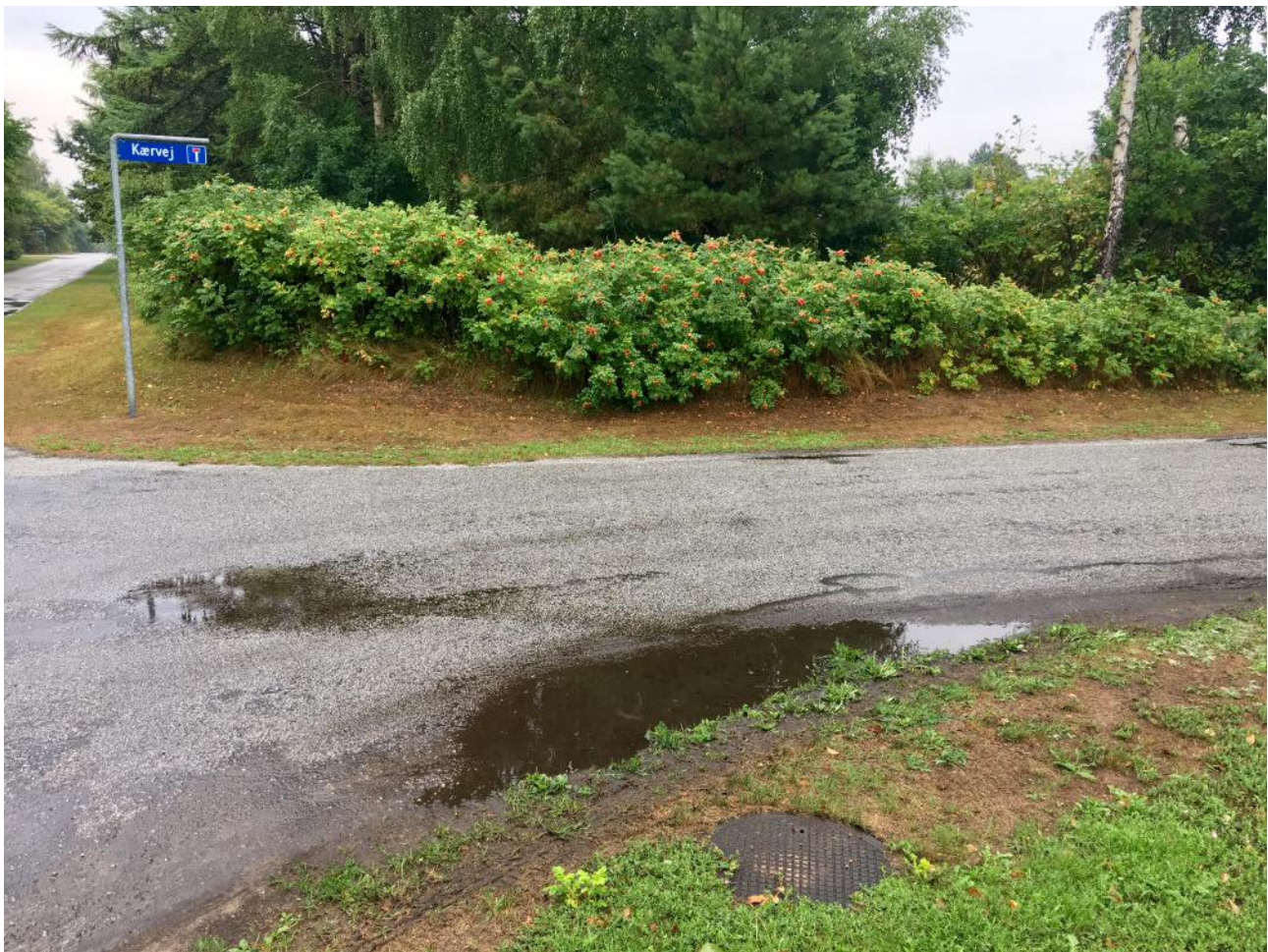
Foto nr. 4: Kærvej set mod nord ved sidevejstilslutningen til Hostrupsvej Vejskilt på hjørnet ud for Kærvej nr. 1 Stor vandpyt rundt om hjørnet på Kærvej ud for Kærvej nr. 2 Også vandpyt på midten af vejen Terrænet er ret fladt her OBS på brønddæksel i græsabat
