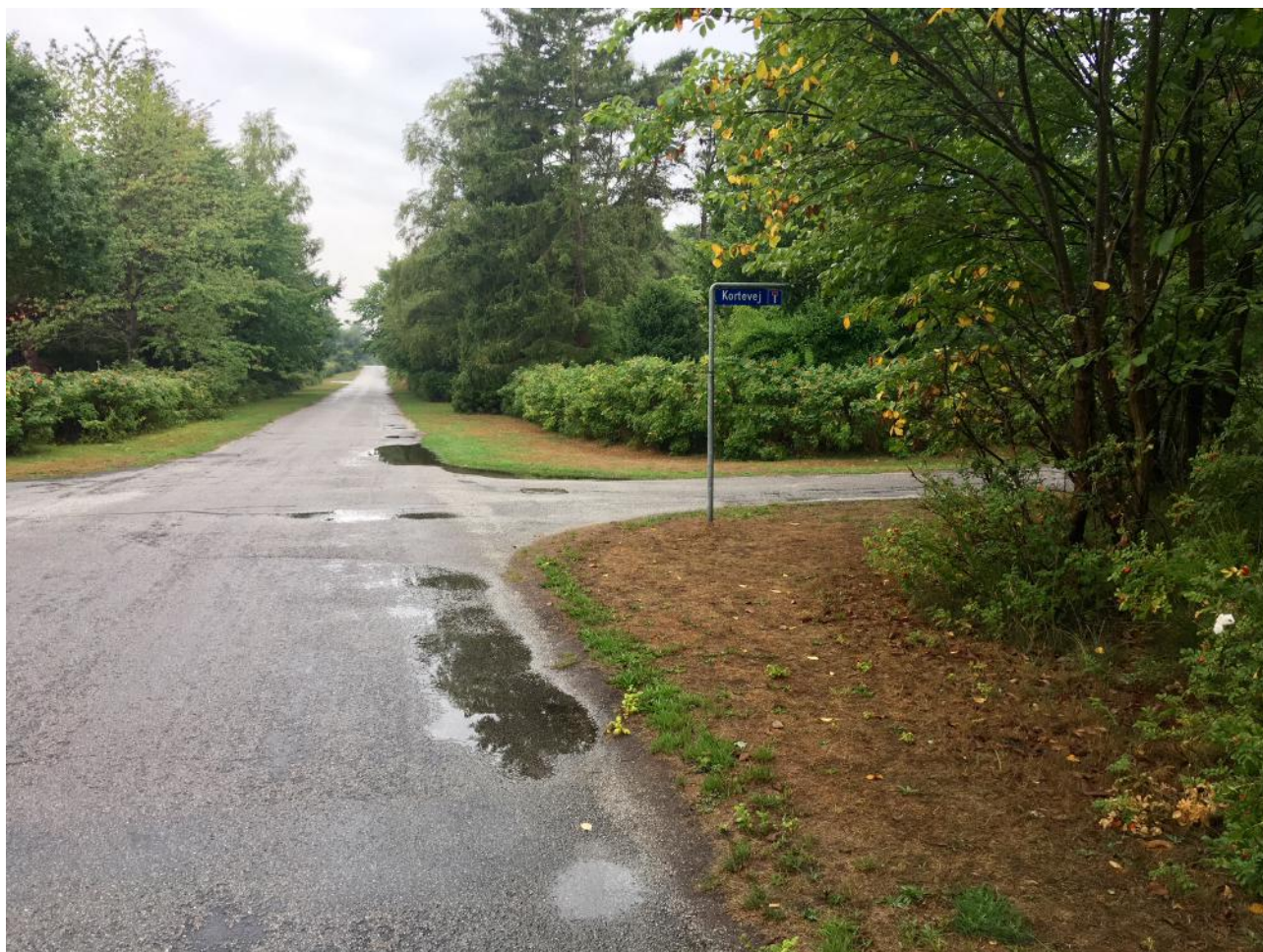
Foto nr. 7: Hostrupsvej set mod vest ved Kortevejs sidevejstilslutning Vejskilt på hjørnet ud for Kortevej nr. 2 Vandpyt på Hostrupsvej ud for Kortevej nr. 2 Kortevej har fald ned mod Hostrupsvej
